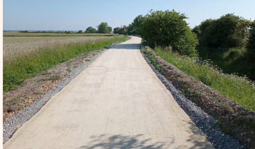
Voie verte en Baie du MSM
